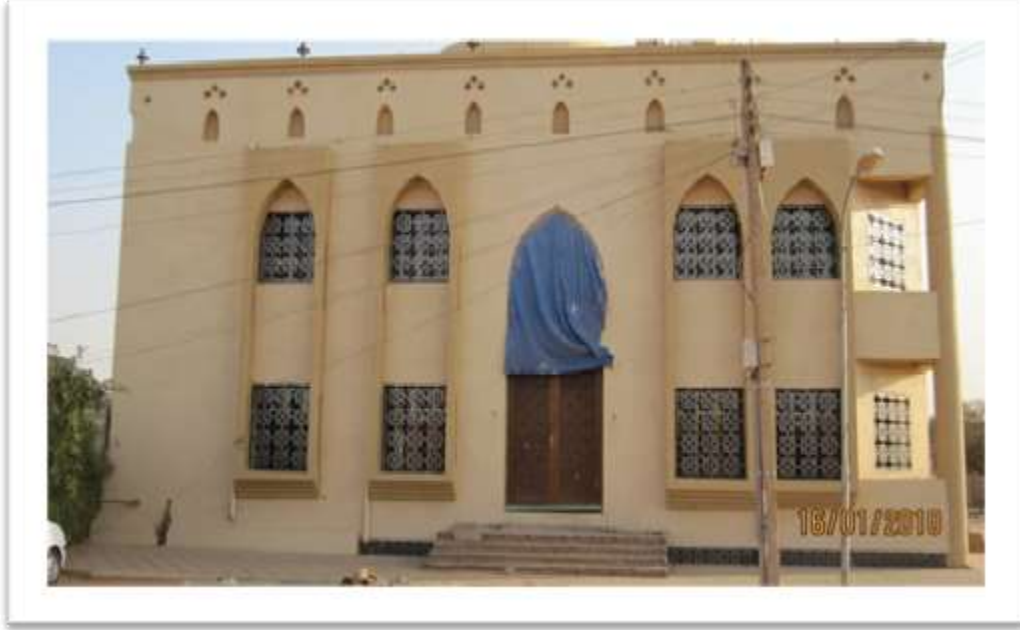
صورة (9-11) واجهة شمالية المصدر: تصميم وتصوير الباحث
