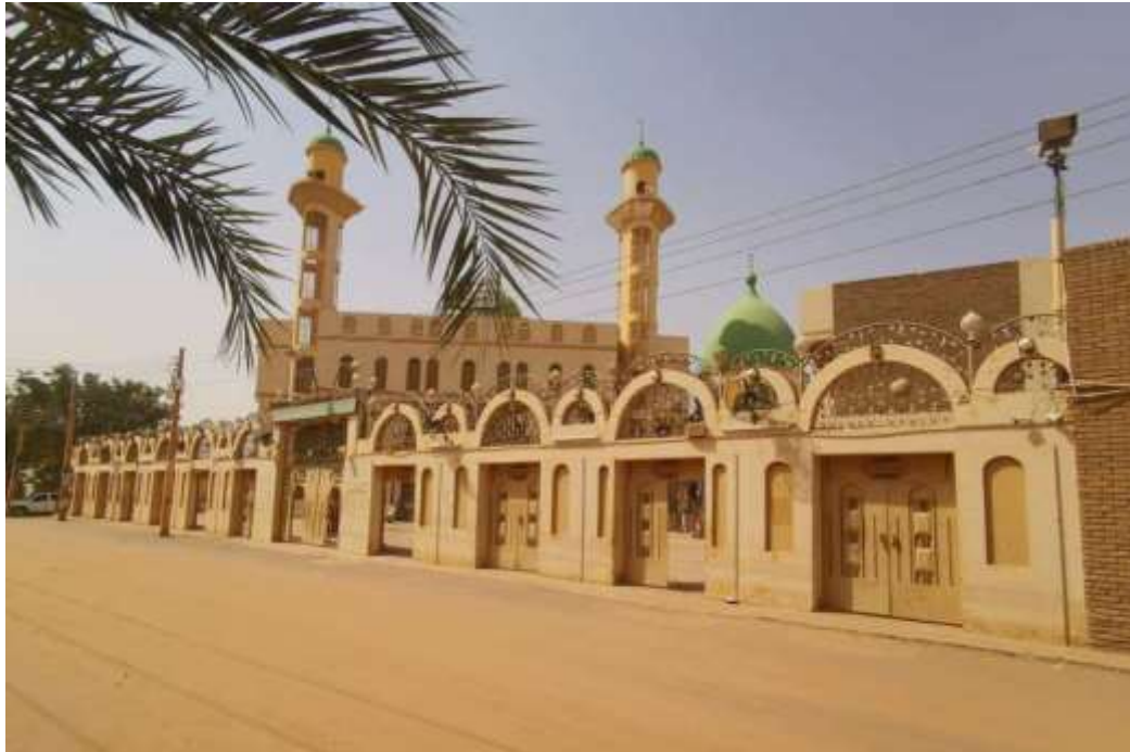
صورة (4-11) صورة منظور خارجي لمسجد الشيخ قريب الله المصدر: تصوير الباحث
