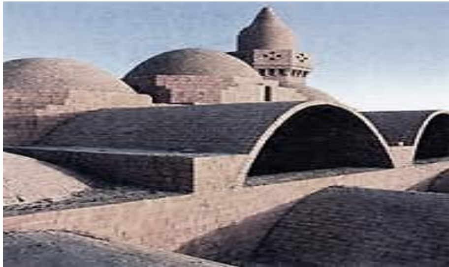
شكل رقم (8.2) يوضح بناء المساجد بالجدران الحاملة
