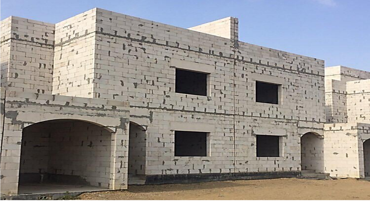
الشكل رقم (9.2) يوضح مبنى سكني بالجدران الحاملة
