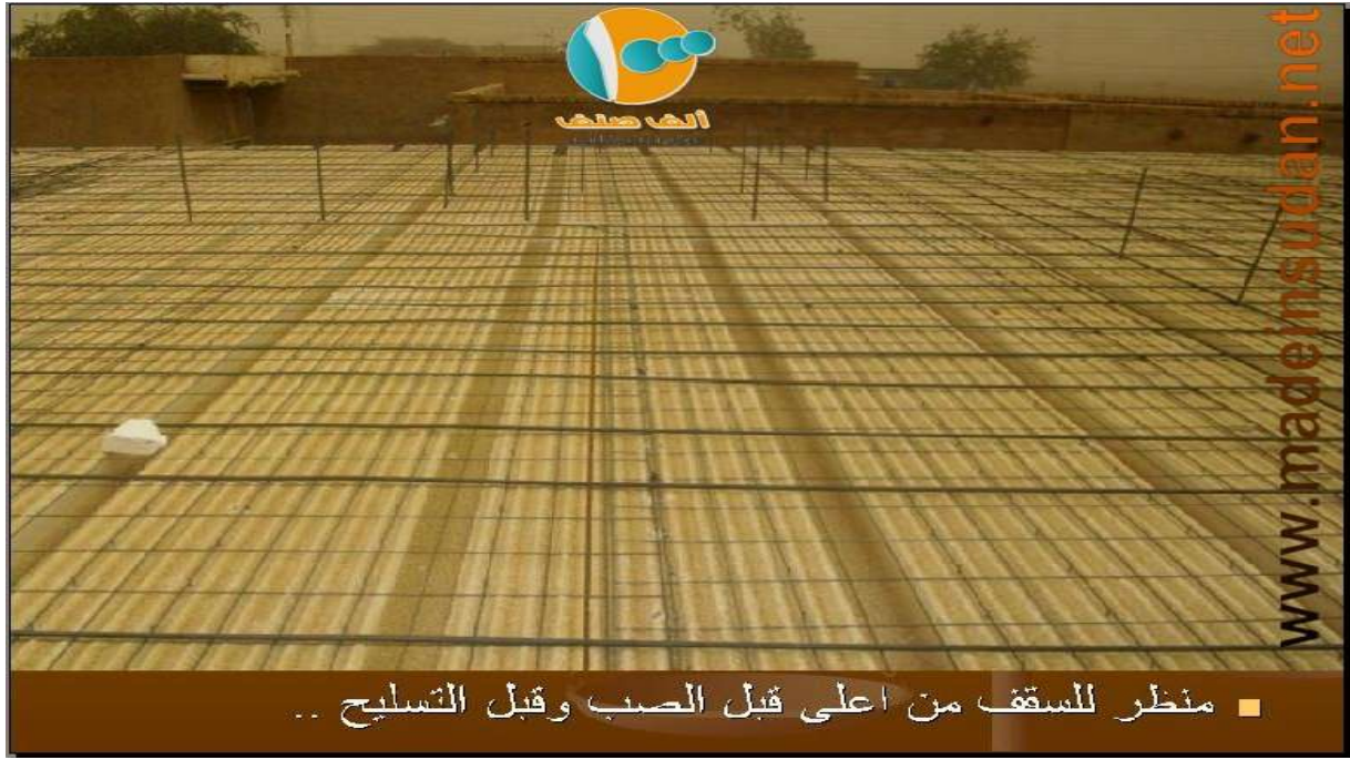
شكل (12-2) يبين تجهيز السقف للصب
