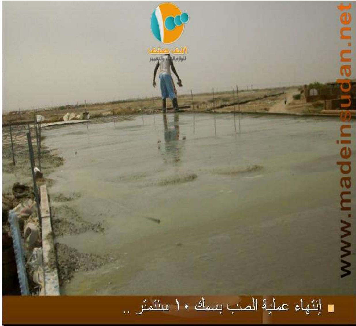
شكل (2-14) يبين شكل السقف بعد الصب
