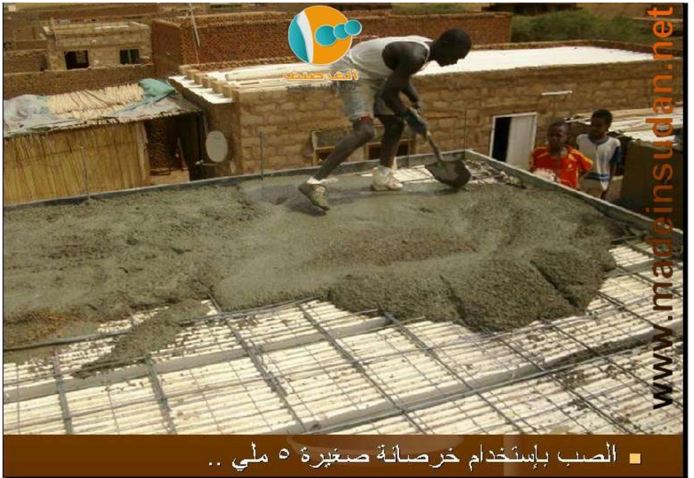
شكل (13-2) يبين صب خرسانة السقف
