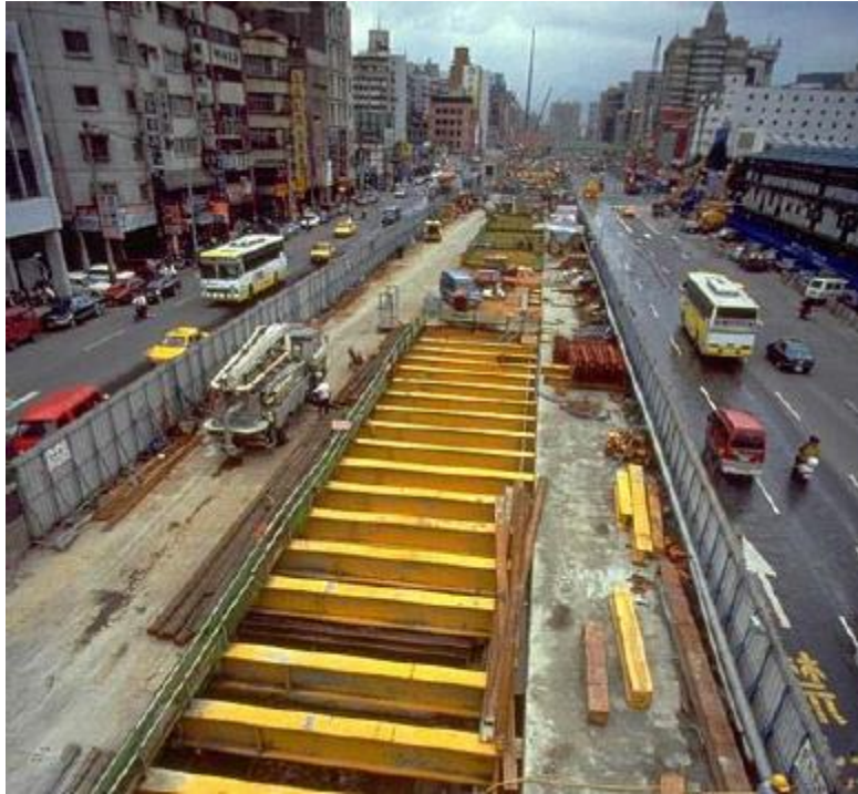
الشكل (2-18) يوضح حوائط الـ slurry walls
