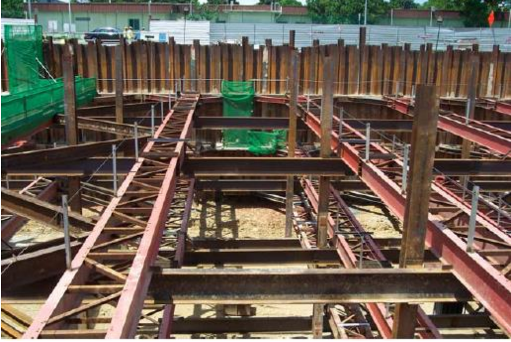
الشكل (2-15) يوضح (sheet Pile) بتثبيت متعدد المستويات .
