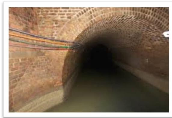
الشكل رقم (2-8) يوضح أنفاق الصرف الصحي
