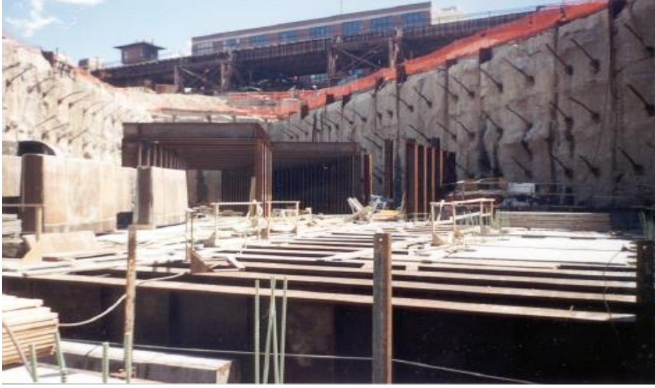
الشكل رقم (2-17) يوضح حوائط مثبتة باستخدام روابط خلفية.
