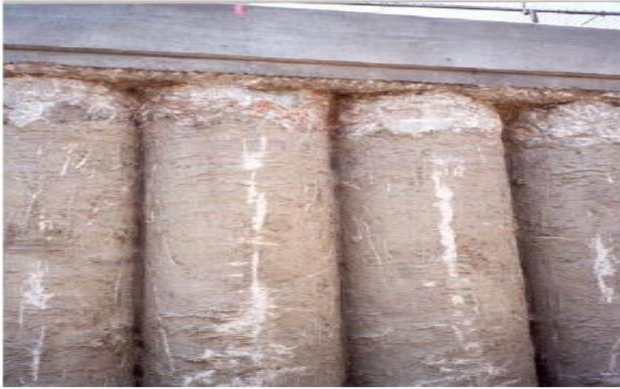
الشكل (2-19 b): دعائم حوائط Tangent pile
