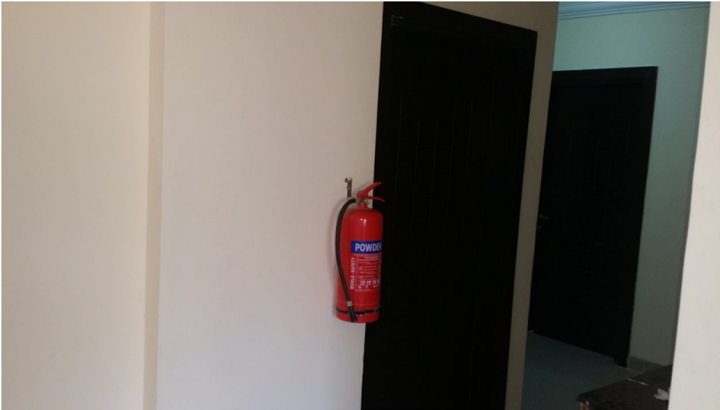
مطفأة البودرة قرب باب المطبخ صورة (21-3)
