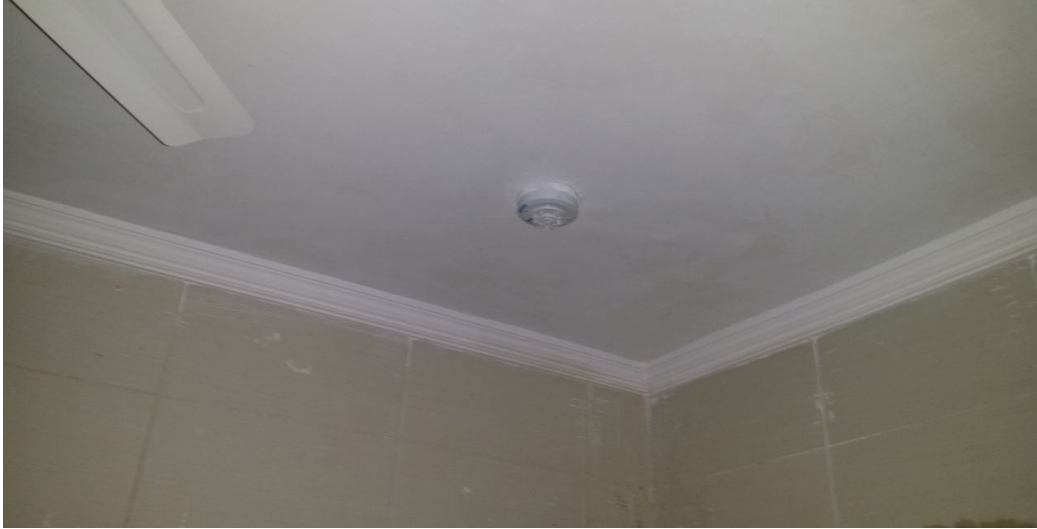
صورة (3-12) : توضح أجهزة الاستشعار عن الحرارة موزعة في كل المطابخ ب- أجهزة الاستشعار عن الدخان :
