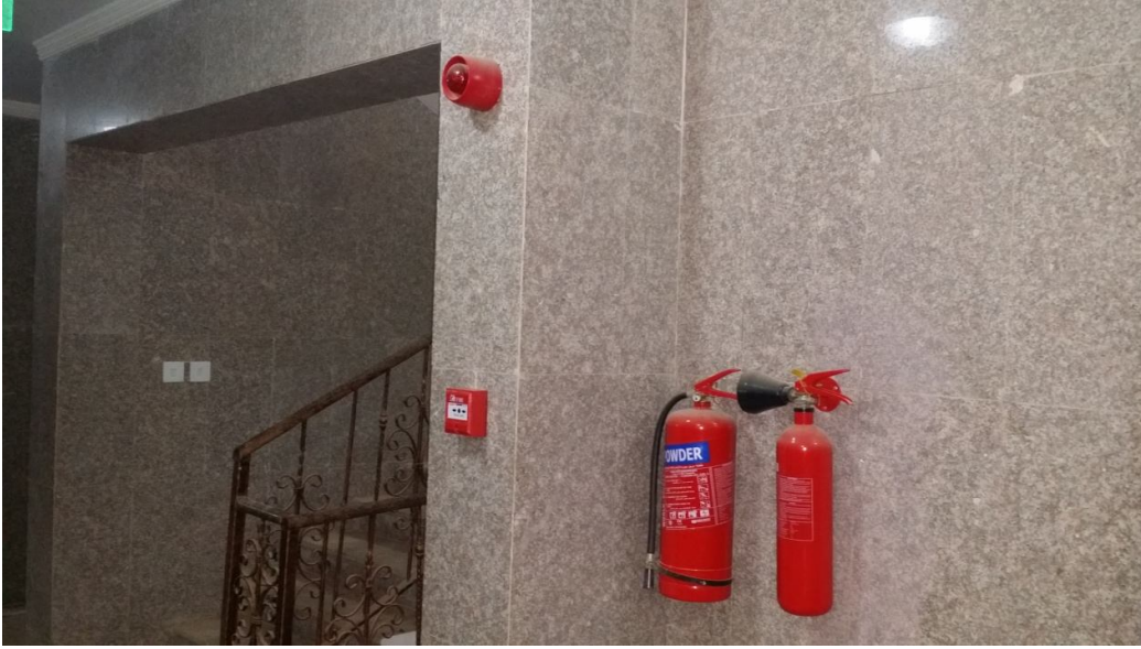
مطفأة البودرة وثاني اكسيد الكربون في ممرات الطوابق صورة (20-3)
