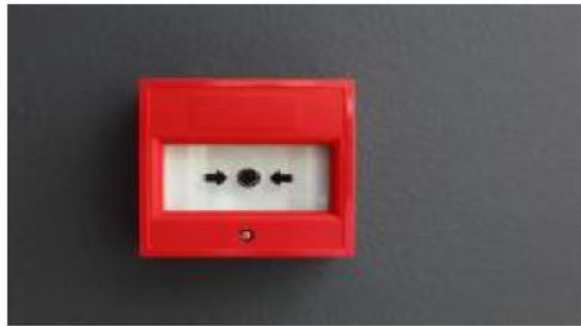
صورة (1-2): توضح جهاز الإنذار اليدوي (www.safety-eng.com)
