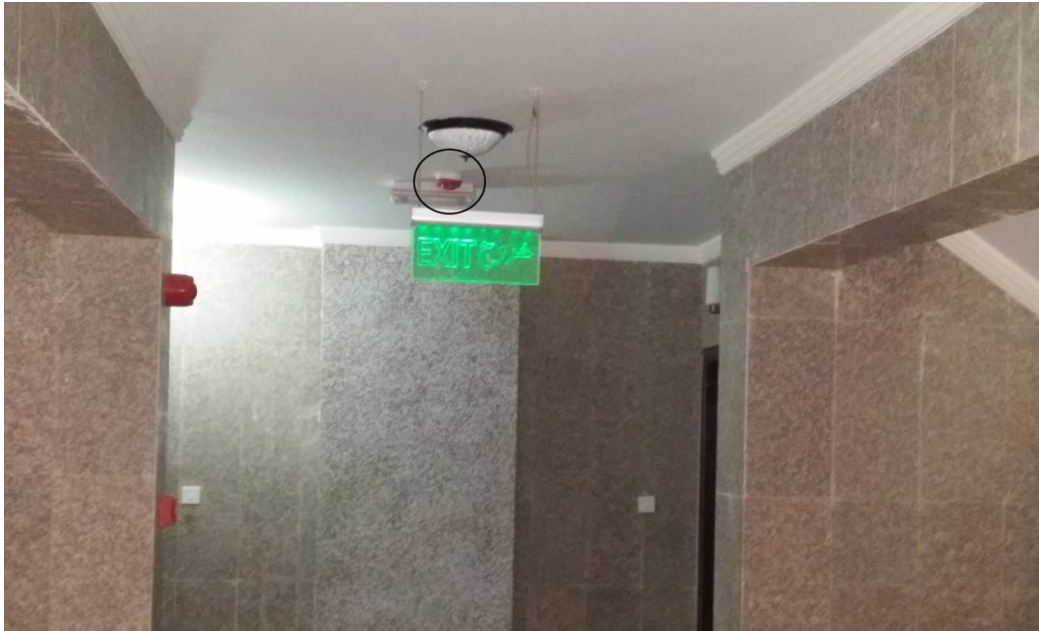
صورة (3-12) : توضح أجهزة الاستشعار عن الحرارة موزعة في كل المطابخ ب- أجهزة الاستشعار عن الدخان :
