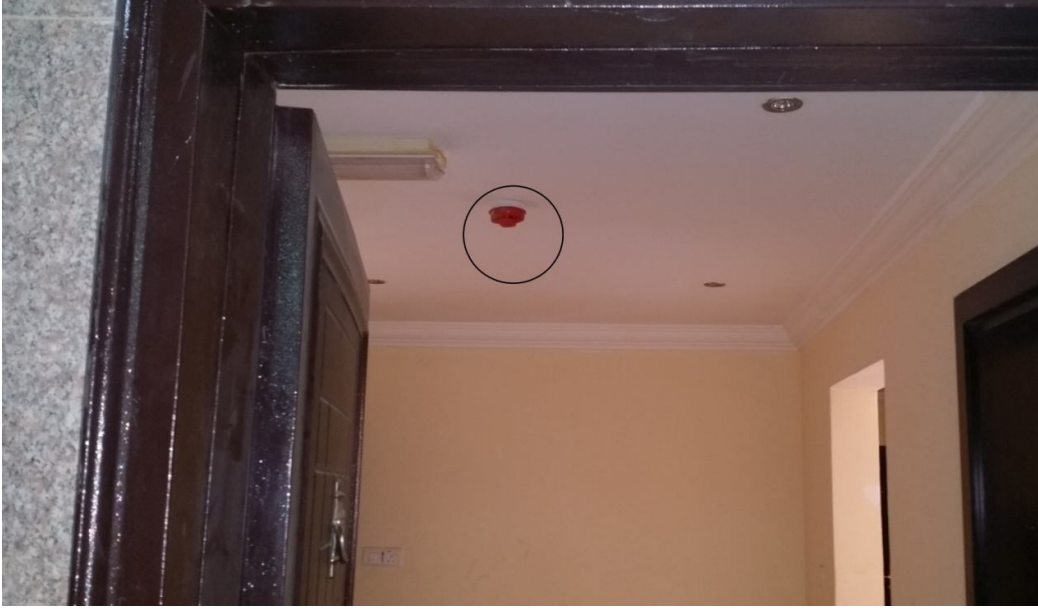
صورة (3-14) : توضيح جهاز الاستشعار عن الدخان في مدخل الشقة
