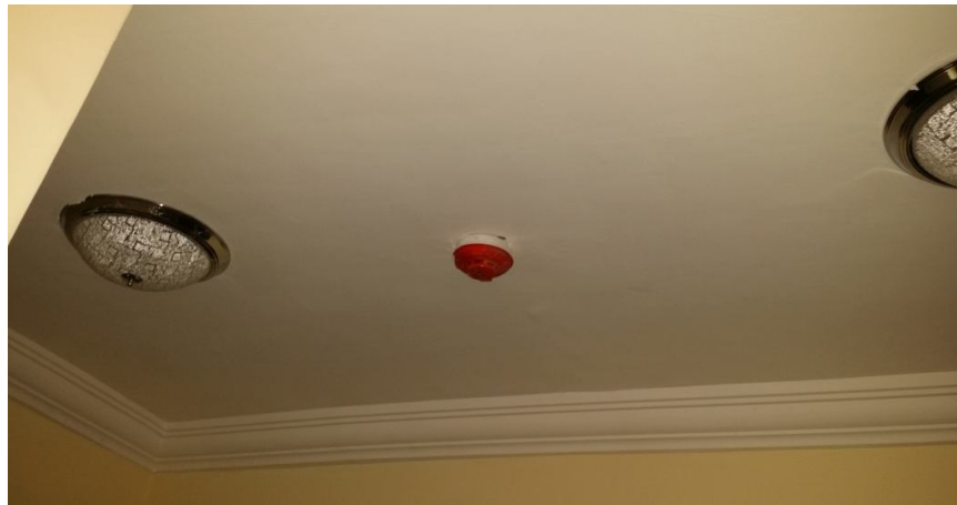
صورة (3-15) : توضيح جهاز الاستشعار عن الدخان في الهول داخل الشقة
