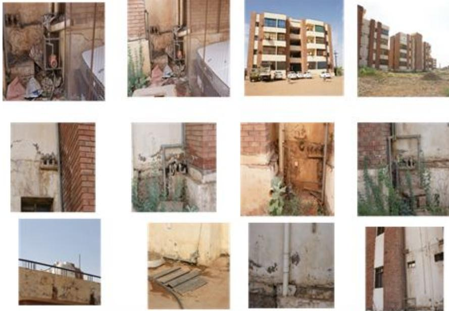
شكل رقم (3-23) مباني سكن ضباط القوات المسلحة - الخرطوم - الشجرة - صور توضح الخلل في التوصيلات الصحية وتسرب المياه وتأثيرها على المبنى
