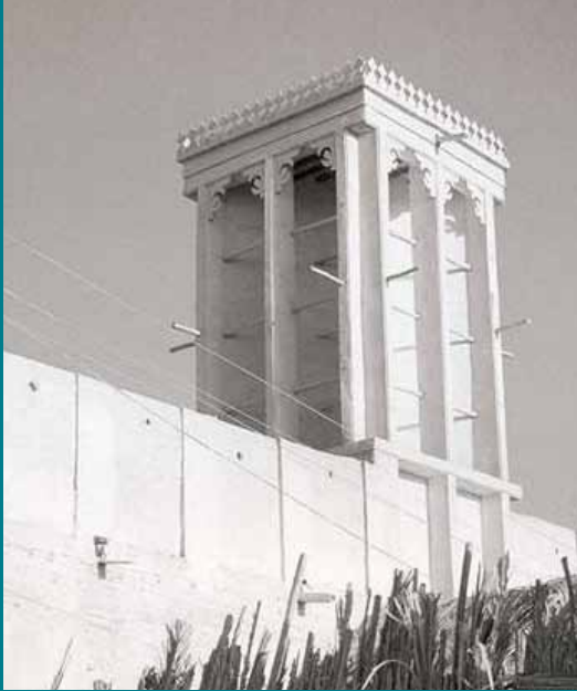
صورة تاريخية تظهر التقاط الرياح من خلال استخدام برج الرياح المدمج في السكة (البراجيل).
