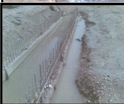
الشكل رقم ( أ-19) اثر التصريف أثناء التشييد
