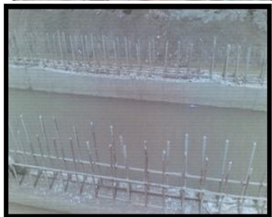
الشكل رقم ( أ-19) اثر التصريف أثناء التشييد
