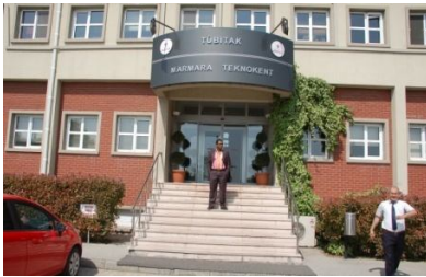
(17-5) مبنى إدارة مرمره تكنوكننت
