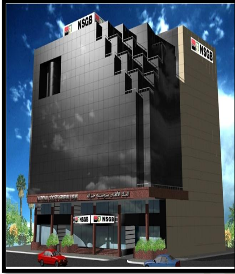
صورة رقم (١) واجهة المبنى
