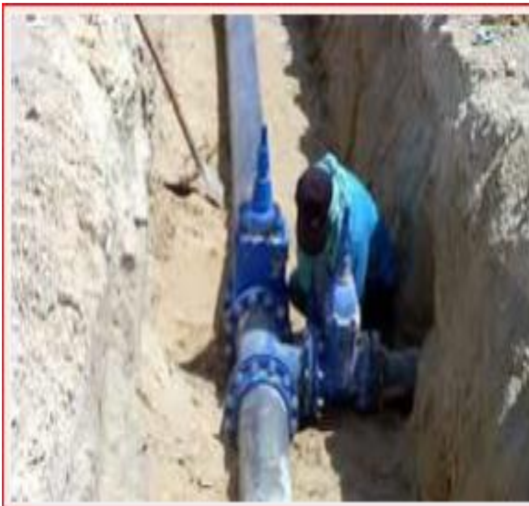
تركيب الصمامات علي شبكة توزيع المياه
