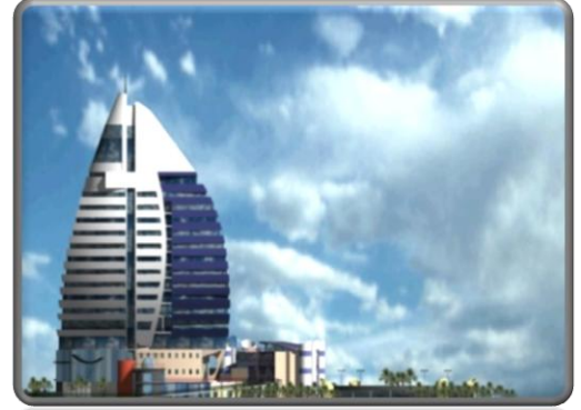
صورة رقم (2-18) الواجهة الجنوبية
