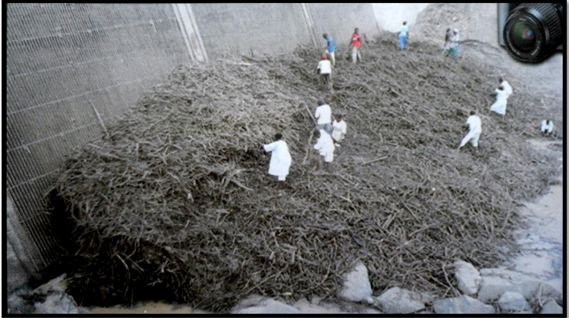
صورة (4): الأطماء أمام مداخل الطلمبات التوربينية
