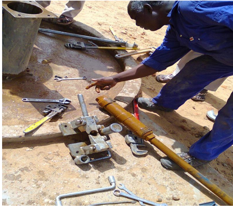
ملحق (13): عملية فحص المضخة اليدوية بعد إخراجها بمدينة الفاشر
