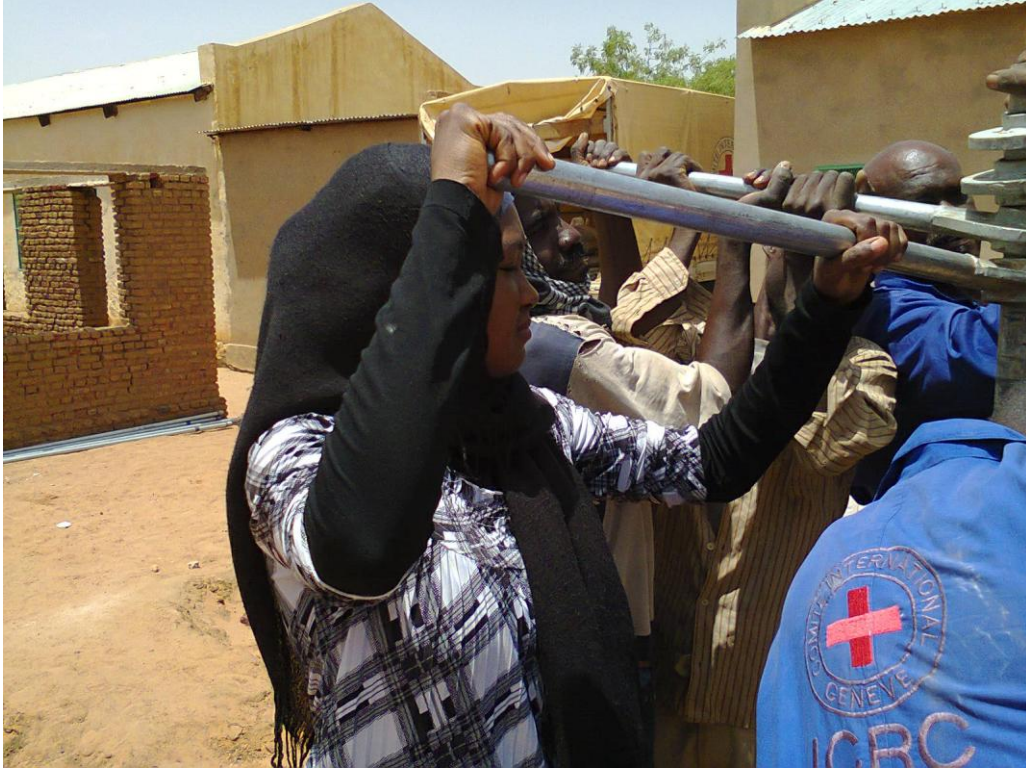
ملحق (16): الدارسة تشارك في عملية إعادة إنزال المضخة الجديدة وأنابيب الضخ
