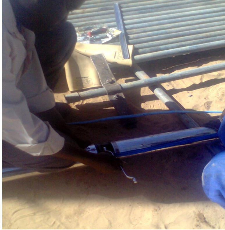
ملحق (1): عملية فحص المضخة الغاطسة والمحرك الكهربائي (الموتور) بمدينة الفاشر
