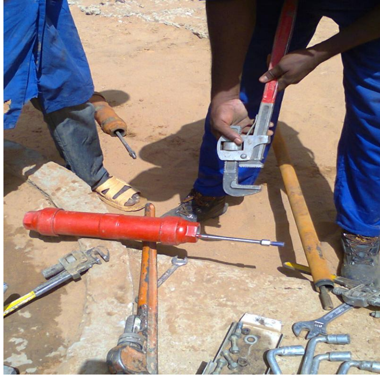
ملحق (14): عملية تبديل المضخة اليدوية وأنابيب الضخ المثقوبة بمدينة الفاشر
