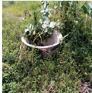
شكل رقم ( 9 ) يوضح بعض غرف التفتيش ممتلئة بالاوساخ والنباتات
