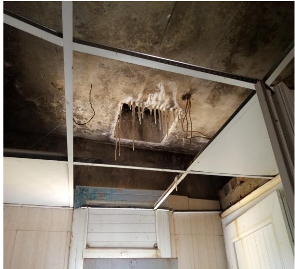
شكل رقم (12) يوضح الترسبات الملحية علي السقف الخرساني
