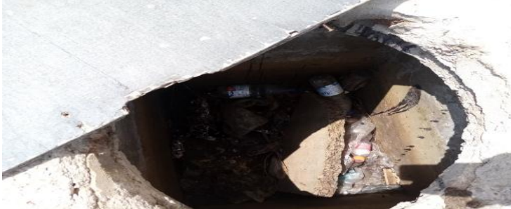
شكل رقم ( 8 ) يوضح ان أغطية غرف التفتيش غير مناسبة
