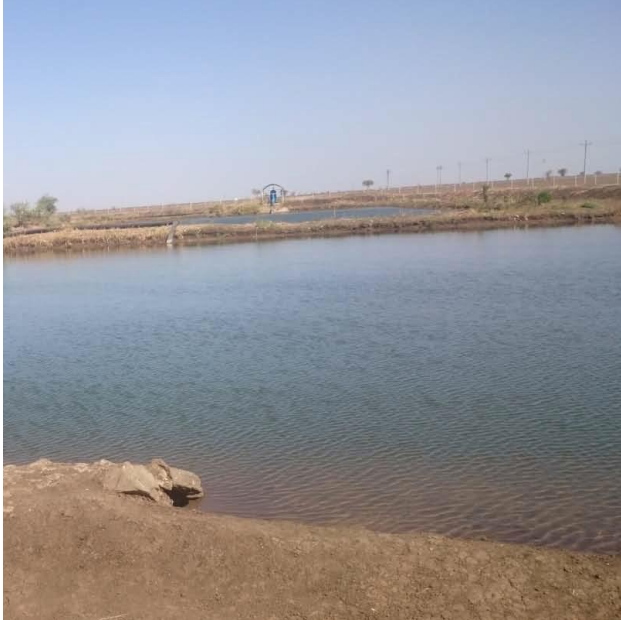
شكل رقم (4) يوضح احواض الترسيب الابتدائي لمحطة المنيره الوضع الحالي للصراف الصحي في المدينة السكنية :
