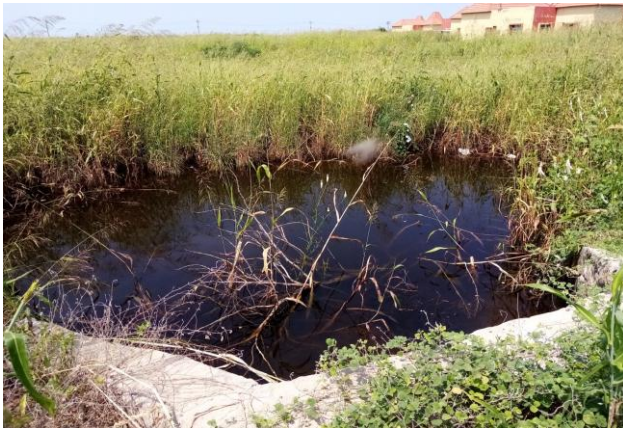
شكل رقم (15) يوضح تراكم المياه في بعض أجزاء مجري التصريف العمومي
