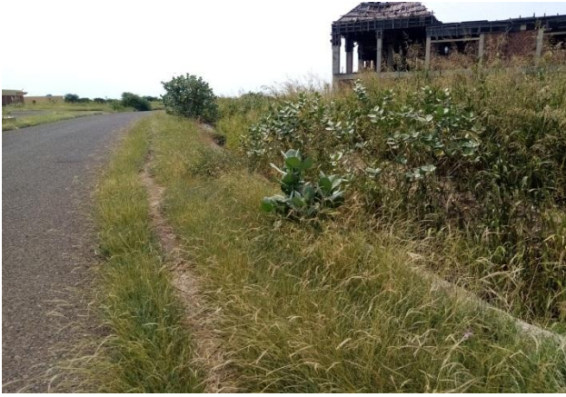
شكل رقم (14) يوضح نمو النباتات والأعشاب علي مجري التصريف العمومي
