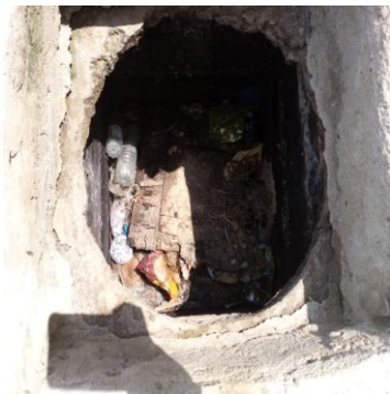
شكل رقم ( 9 ) يوضح بعض غرف التفتيش ممتلئة بالاوساخ والنباتات
