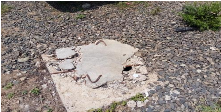
شكل رقم ( 8 ) يوضح ان أغطية غرف التفتيش غير مناسبة
