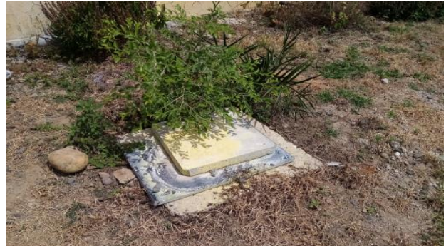
شكل رقم ( 7 ) تسرب مياه الصرف من المصاص ونمو النباتات حول حوض التحليل
