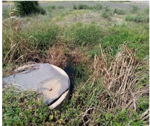
شكل رقم ( 8 ) يوضح ان أغطية غرف التفتيش غير مناسبة
