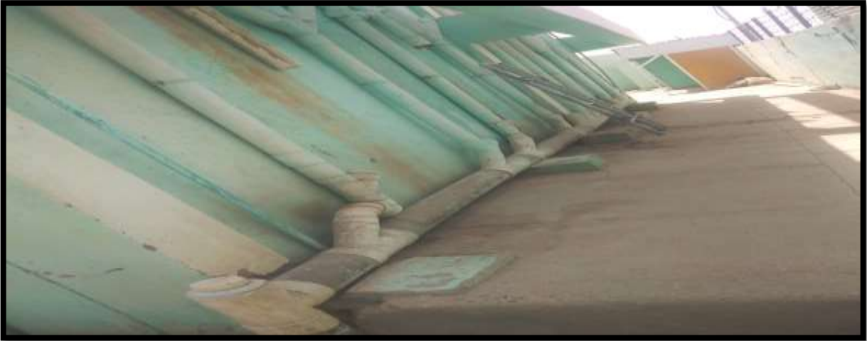
شكل (٣-٤) توصيلات الراسية للحمامات (الباحثة)
