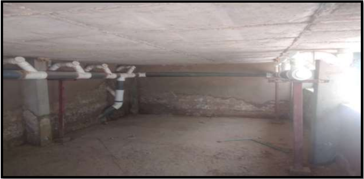
شكل (٦-٤) توصيلات الحمامات تحت الارض (الباحثة)
