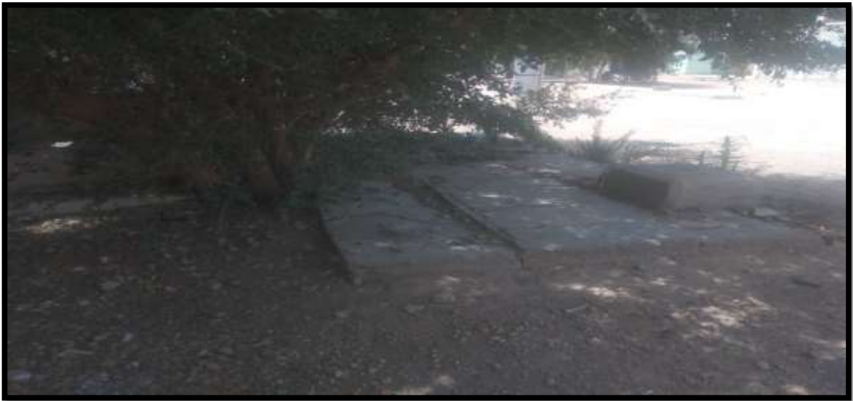
شكل (٤-١٤) خزان تجميع مياه الكافتريا (الباحثة)
