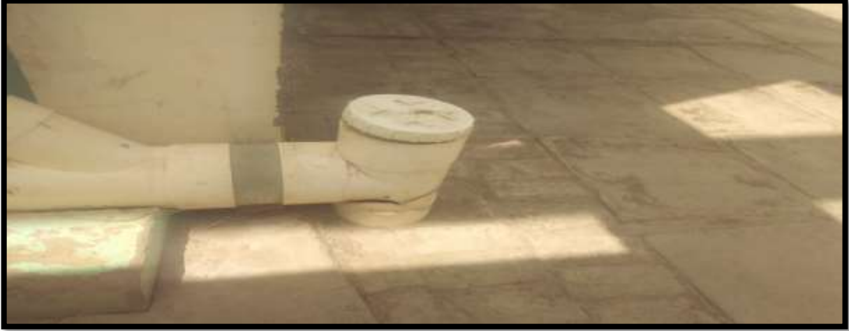
شكل (٢-٤) توصيلات الارضية للحمامات (الباحثة)
