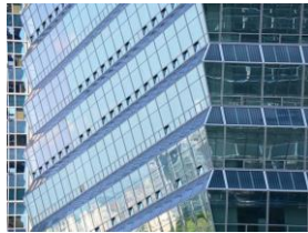
الشكل (2-38) الخلايا الشمسية واستخدامها في الحوائط المتدرجة (المسنة) في مبنى اتحاد الصناعات الكورية في كوريا الجنوبية
