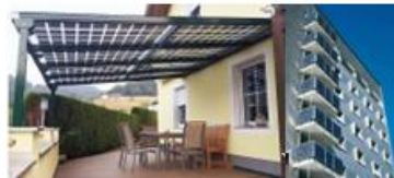
الشكل (2-44) الخلايا الشمسية واستخدامها كدرابزين البلكونات و للتراسات المصدر (Krawietz, 2011)
