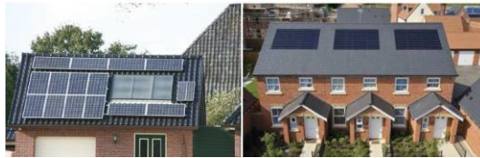
الشكل (30-2) الخلايا الشمسية فوق مواد الإنهاء الخارجية للأسقف المائلة المصدر (Sinaps,Donker,2013)
