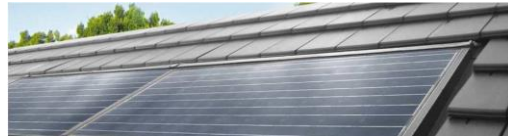
الشكل (29-2) الخلايا الشمسية بديل مواد الإنهاء الخارجية للأسقف المائلة المصدر (Sinaps,Donker,2013)
