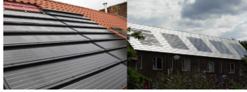
الشكل (31-2) إضافة الخلايا الشمسية ضمن مواد الإنهاء التقليدية للأسقف المائلة المصدر (Sinaps,Donker,2013)
