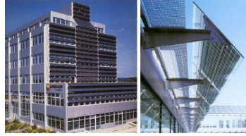
الشكل (2-43) استخدام الزجاج الكهروضوئي ككاسرات الشمس كما في مركز شايدجر في السويد المصدر (Pinterest, )
