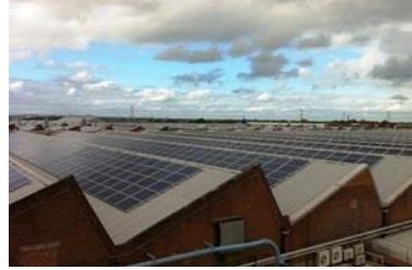
الشكل (32-2) الأسطح المسننة وتكاملها مع الخلايا الشمسية المصدر ( 2010, Sigulda, Latvia )
