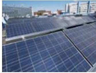
الشكل (27-2) الوحدات الشمسية المائلة المصممة للأسطح الأفقية المصدر ( 2010, Sigulda, Latvia )
