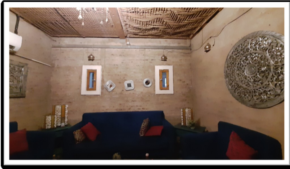
الشكل (4-14) يوضح السقف الداخلي للفراغات
