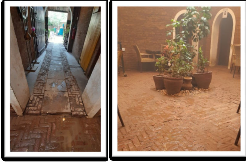
الشكل (4-15) يوضح رصف الارضيات
