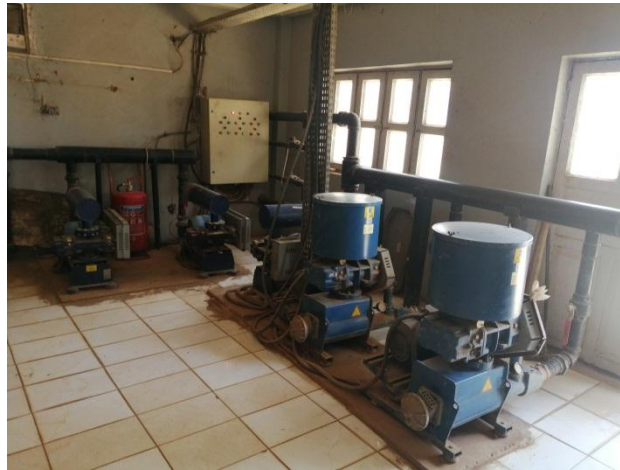
صورة (4-12) : مضخات الهواء
