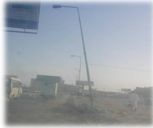
صورة(5-14)أعمده الانارة بشوارع مستشفى شرق النيل القادسية(المصدر الباحث 2022)
