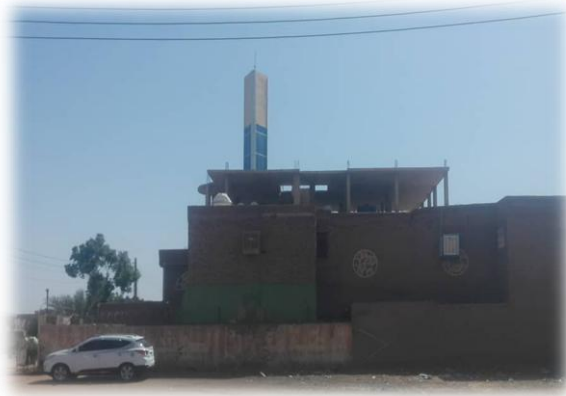
صورة(5-10)أحد أعمده الاتصال فوق مبنى سكني بحي القادسية شرق النيل ( المصدر الباحث 2022 )
