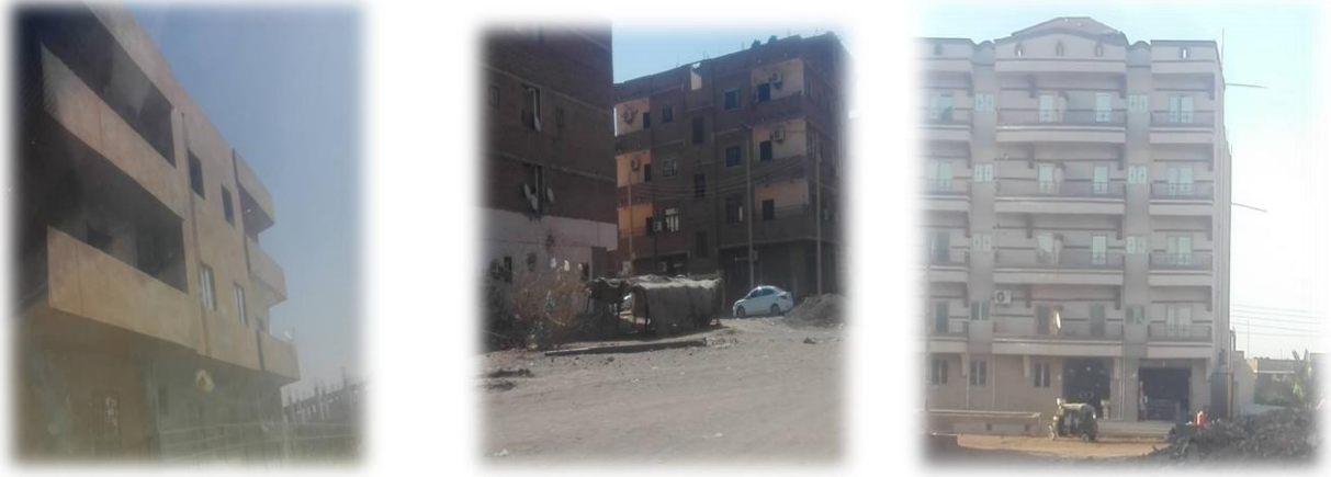
صور (5-6) مباني متفرقة (منطقة شرق النيل حي القادسية ) (المصدر الباحث 2022 )
