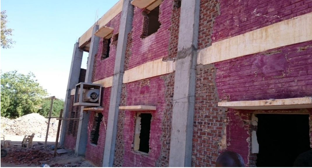
الشكل (4.4): الوصله بعد عملية صيانة صدأ حديد التسليح والتعشيش.
