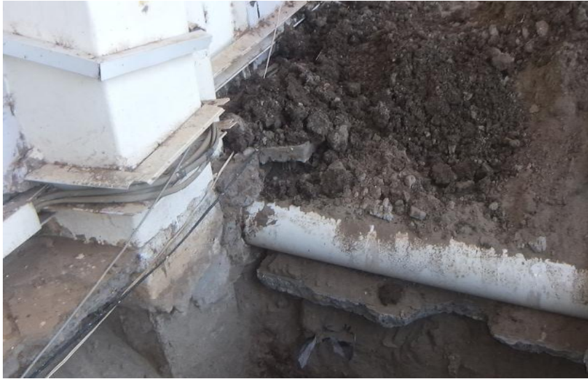
الشكل (3.13): توصيل مواسير نوازل تصريف السقف.
