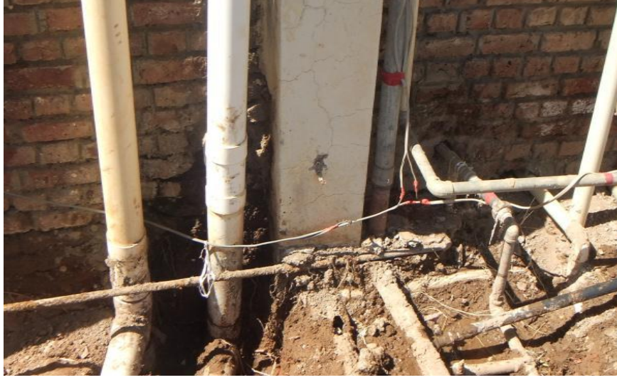
الشكل (3.12) توصيلات الصرف الصحي و المياه العذبة.
