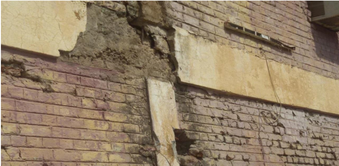
الشكل (4.3): تعشيش في العمود وصدأ لحديد تسليح العمود.
