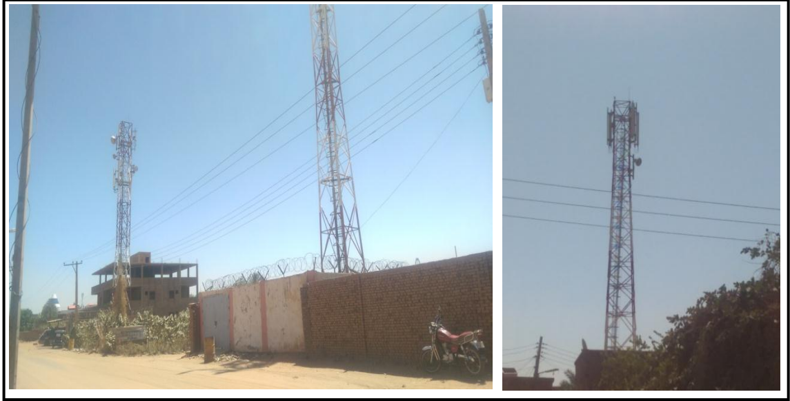
صورة رقم(5-36): تظهر أبراج شبكات الاتصال
