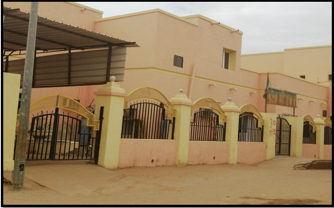
صورة رقم(5- 23): تظهر مركز صحي توتي (المصدر: الباحثة)
