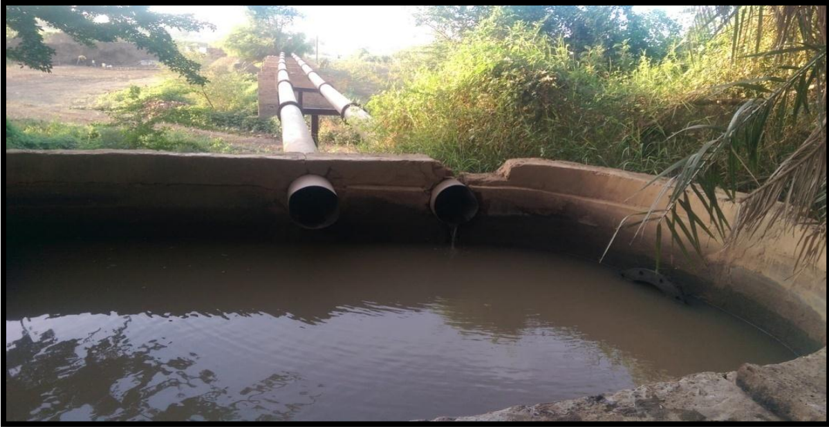
صورة رقم(5-32): توضح الأنابيب التي توصل المياه إلى الجدول الكبير (المصدر: الباحثة)
