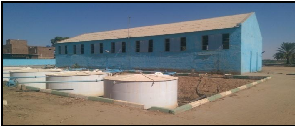
صورة رقم(5- 19): تظهر محطه مياه توتي عام2018م
