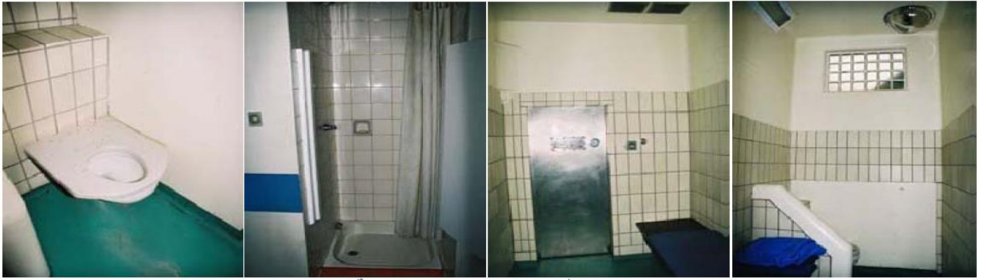
شكل (4-3) ، نموذج لدورة مياه بقسم شرطة بإنجلترا
