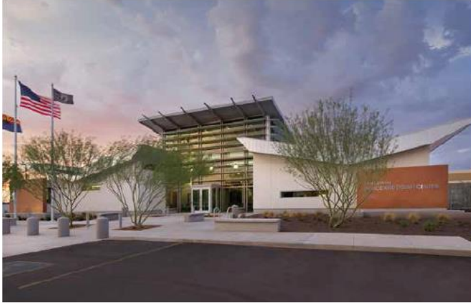
شكل (4-5)، الواجه الرئيسية لقسم شرطة تولسون
