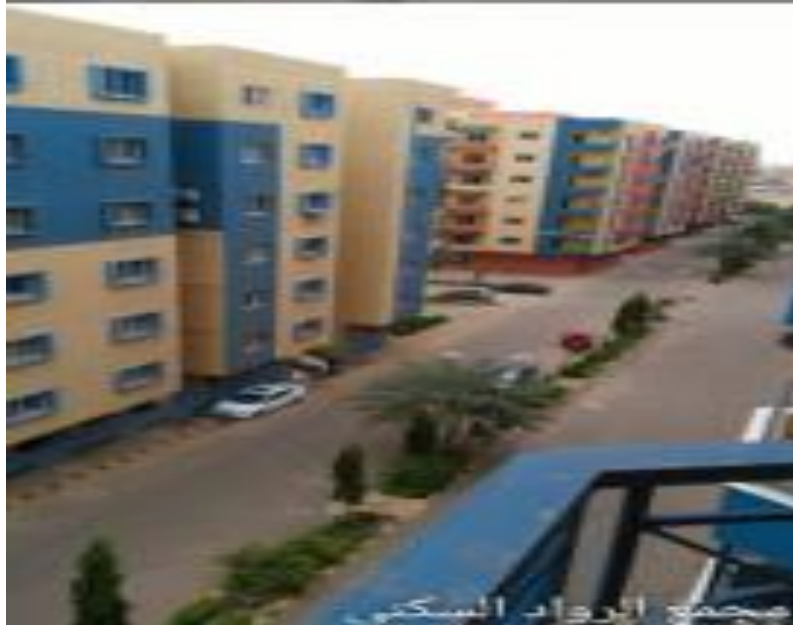
الشكل (٨-٥) يوضح فتحات التهوية للمباني حيث لا يوجد ملقف للتهوية بل فتحات فقط
