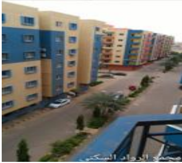
الشكل (٥-٥) يوضح استقامة الشوارع الداخلية بالمجمع
