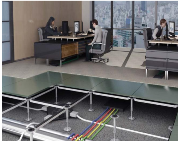
صورة رقم (41) يوضح كيفية التركيب و الوصول في الارضيات المرتفعة المصدر: ( http://www.quattropavimente.ro/ )
