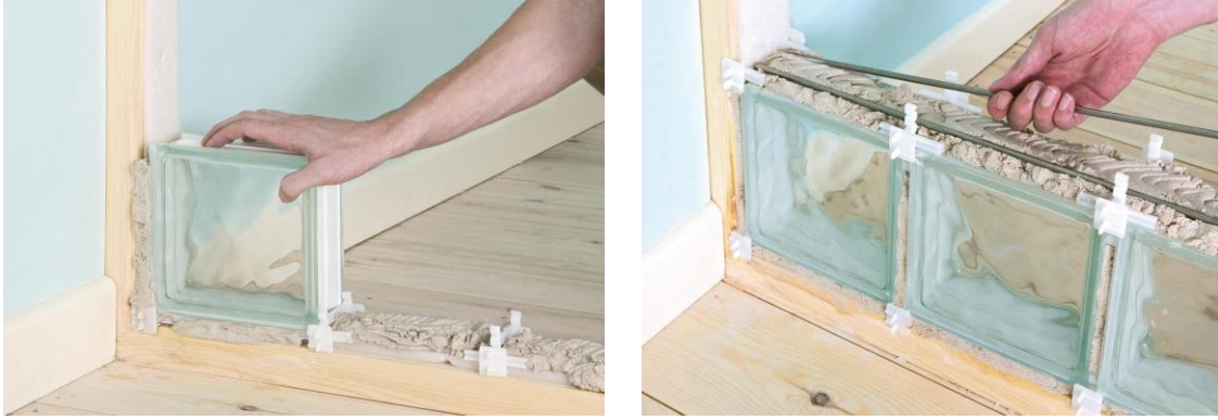
صورة رقم (65) يوضح طريقة التثبيت المصدر: https://theconstructor.org
