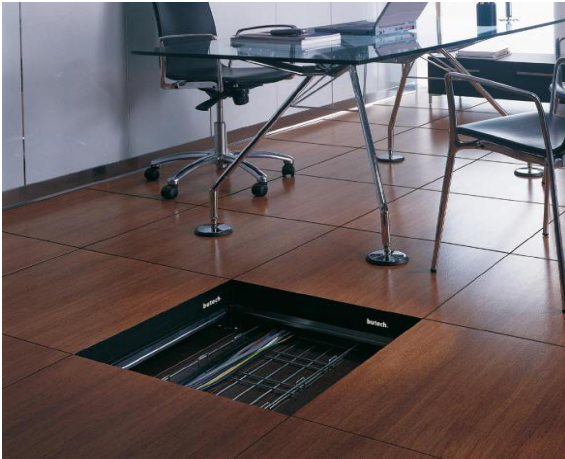
صورة رقم (41) يوضح كيفية التركيب و الوصول في الارضيات المرتفعة المصدر: ( http://www.quattropavimente.ro/ )
