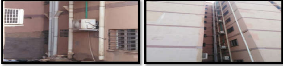
شكل (3-10): صور توضح توصيلات المواسير علي الواجهات.
