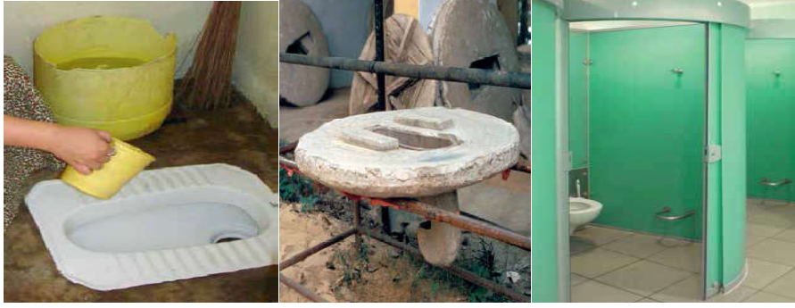
شكل (2-12): صور توضح بعض المراحيض التي تحتاج لإمداد منتظم بالمياه لكي تعمل بشكل جيد. (المصدر : نظم وتقنيات الصرف الصحي)
