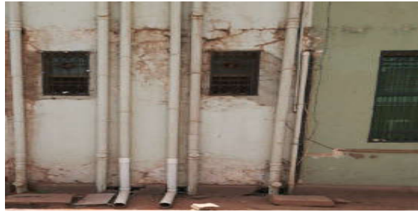
شكل (3-13) صورة توضح تموضع المواسير بجمع ابراج الشرطة (شمبات).
