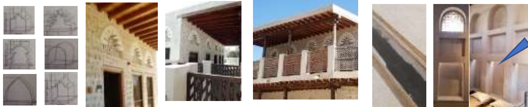
الصورة (36)، تظهر معالم التهوية في الطابق الأول بوضوح. المصدر: تصوير الباحث.
