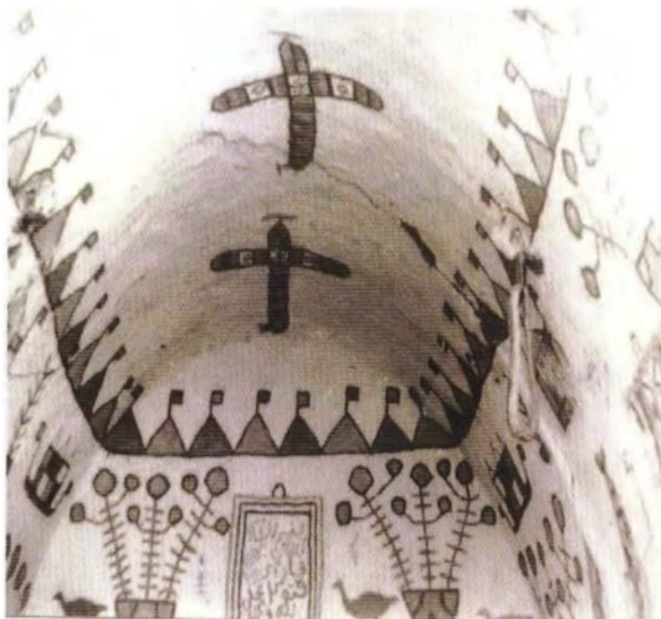
صورة رقم (٤) زخارف القباب من الداخل المصدر: كتاب الزخارف النوبية فى العمارة واطباق الخوص
