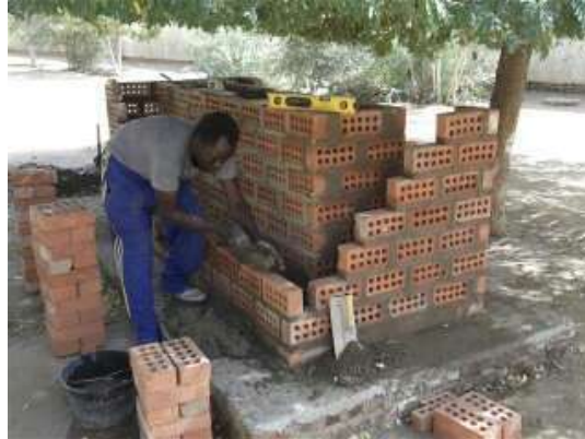
صورة رقم ( 11،4،3) توضح طريقة انشاء المبرد الحراري
