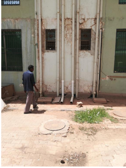
صورة رقم (9-3) توضح طريقة توصيل المجاري راسيا
