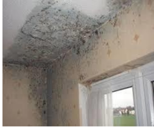
الشكل رقم (3-5) - تأثير المياه على الخرسانة
