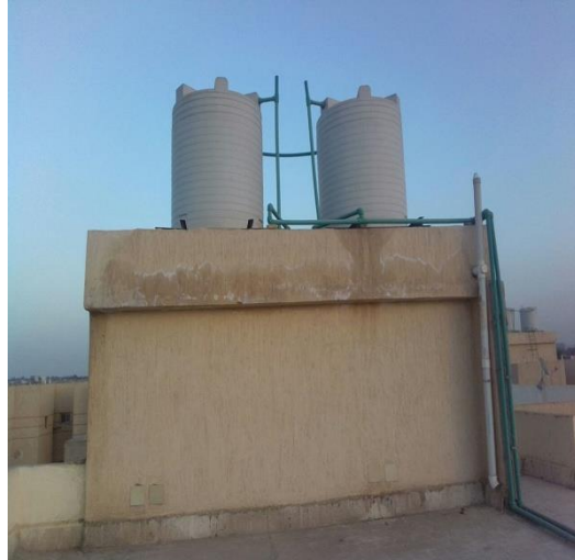
الشكل رقم (3-11)- يوضح موضع الخزان العلوي وتأثير تسببه
