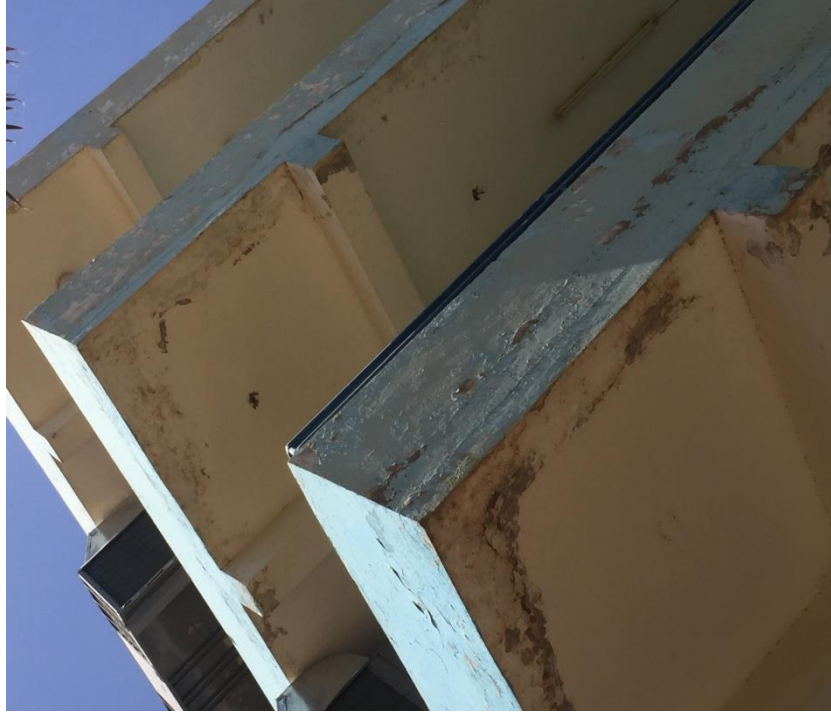
شكل رقم (5-5) توضح تأثير المياه على المباني وسوء العزل
