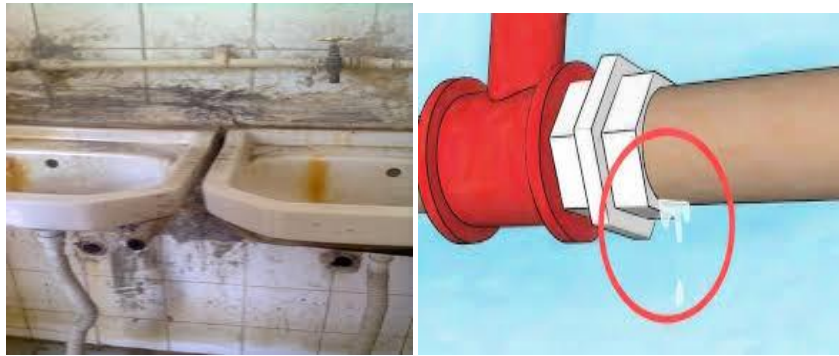
الصور رقم (3-8)- توضح تلف المواسير
