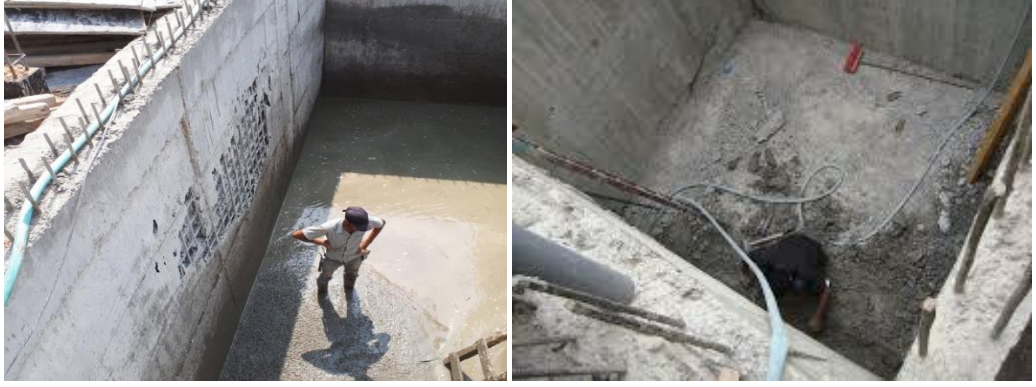
الشكل رقم (3-10) يوضح الخزان الاضي ومشاكل تشييده
