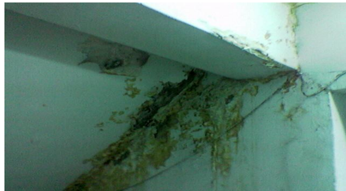
شكل رقم (3-13) يوضح الشروخ في الهياكل الخرسانية
