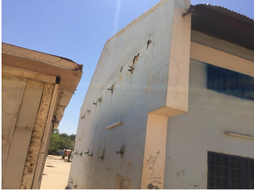
شكل رقم (5-5) توضح تأثير المياه على المباني وسوء العزل
