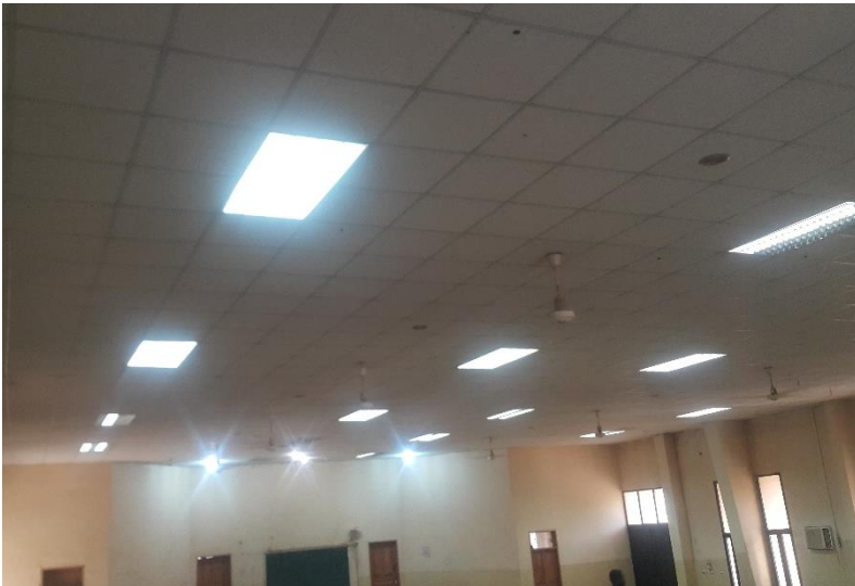
الشكل (4-18) : شكل سقفة القاعة (2)
