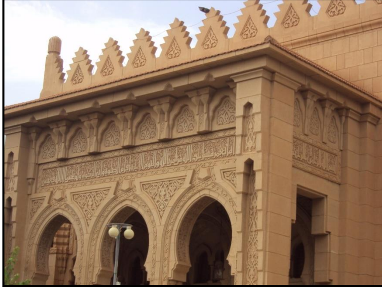
المصدر: مسجد فاروق (تصوير الباحث)
