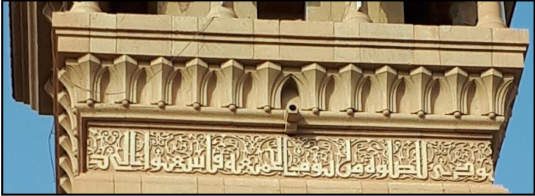
المصدر: مسجد فاروق (تصوير الباحث)
