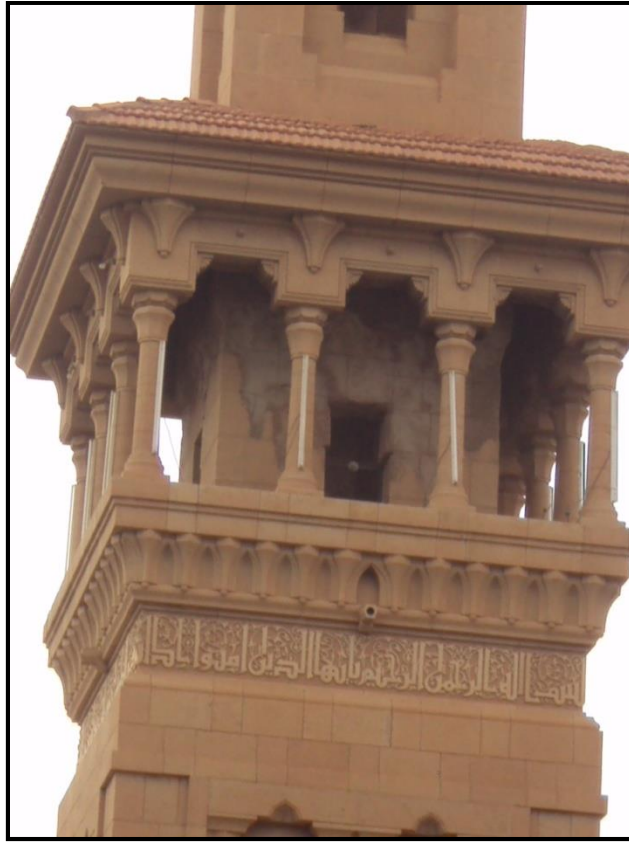
المصدر: مسجد فاروق (تصوير الباحث)
