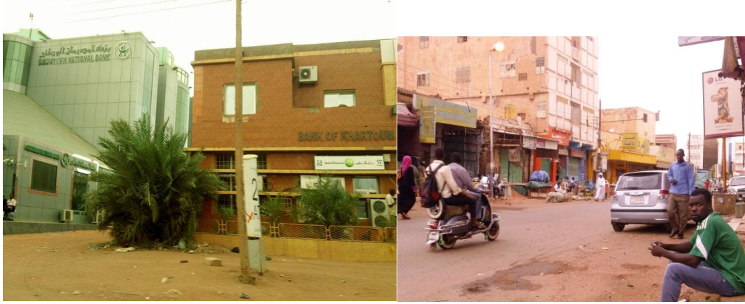
صورة رقم (3-24) توضح المباني ذات الهياكل الخرسانية
