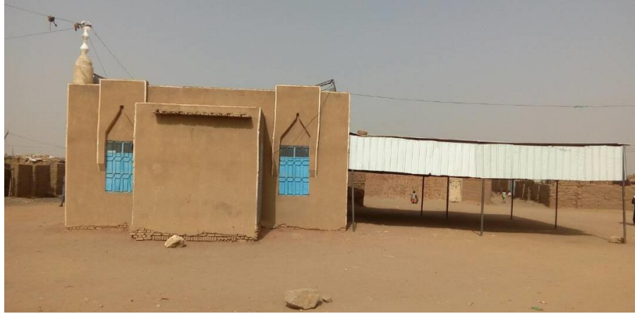
صورة رقم (5/3) توضح المسجد بالمنطقة -المصدر الباحثة 2018/07
