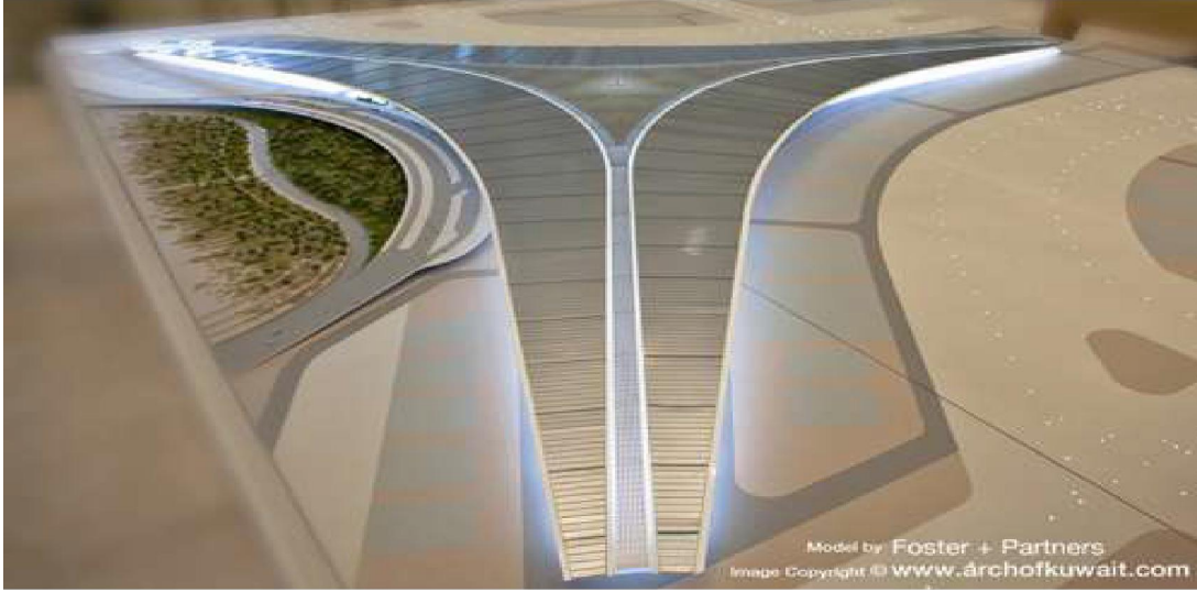
الشكل 4-8: الواح شمسية تغطي سطح المطار
