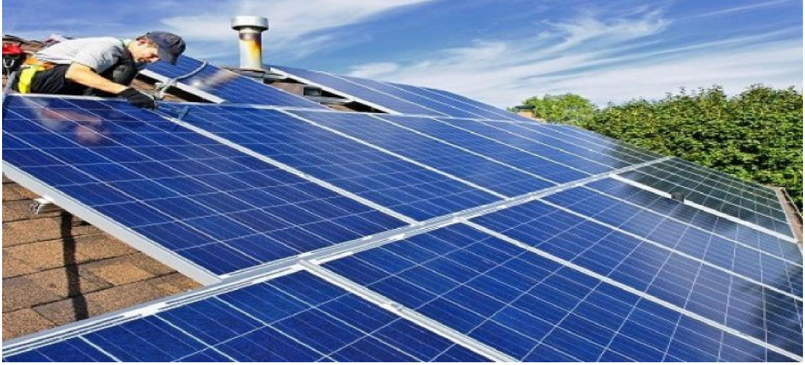
الشكل 2-6 : تركيب الواجه الشمسيه على سطح المبنى.
