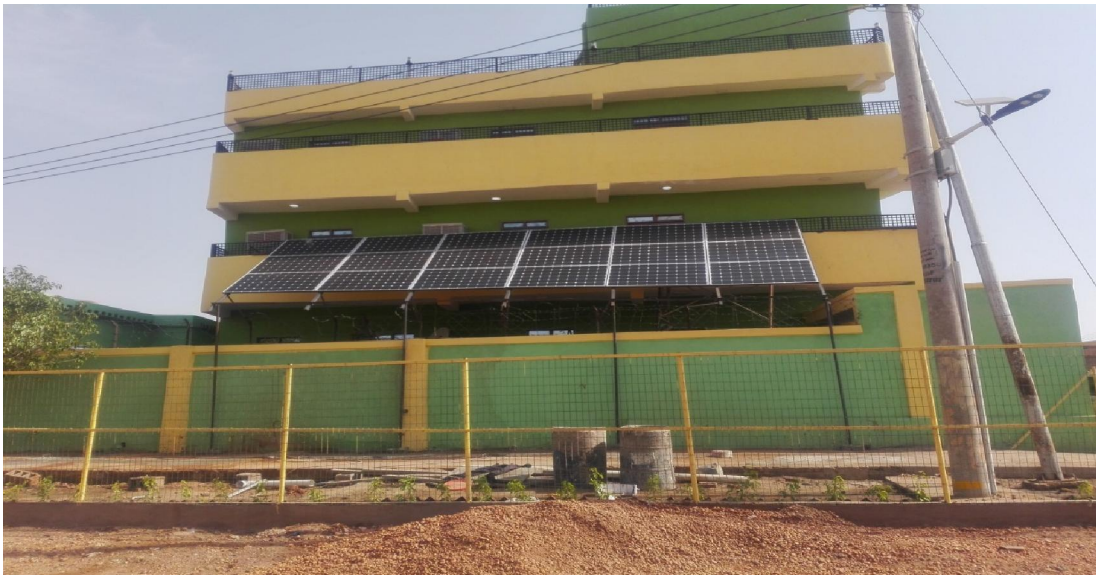
الشكل 5-6 الواجهات الشمسية في المبنى المصدر (الباحث، 2018)
