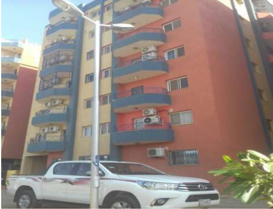
شكل رقم (4-15) صورة توضح الفتحات في الواجهة الشمالية
