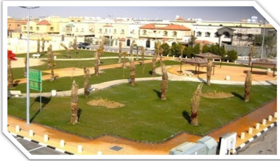
شكل (3-12) صورة توضح حديقة سكنية بأحد أحياء الدمام
