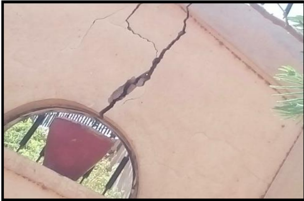
صورة (3-7) نموذج للتشققات بالحوائط حي الجامعة
