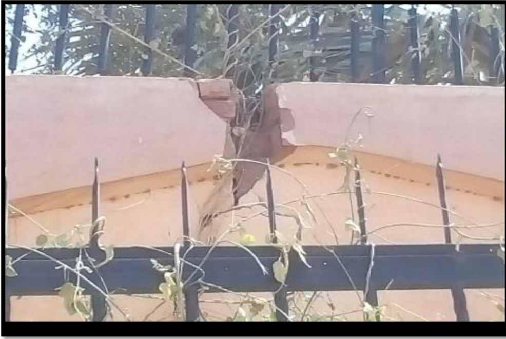
صورة (3-6) نموذج للتشققات بالحوائط حي الجامعة
