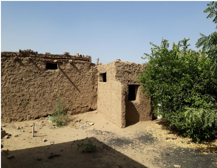
صوره رقم(2- 16) منظر داخلي لمنزل من الجالوص - (بمدني، الجزيرة، في حي المكي) المصدر (تصوير ميداني)
