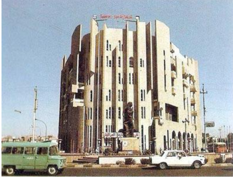
صورة رقم(4-14) منظور أمامي لعمارة مبنى التأمين في الموصل المصدر almadaper-117960
