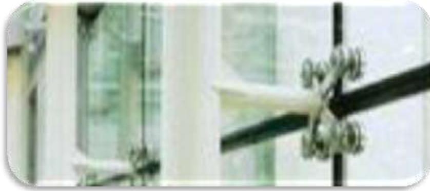
شكل (3-37) يوضح هيكل معدم للواجهات الزجاجية
