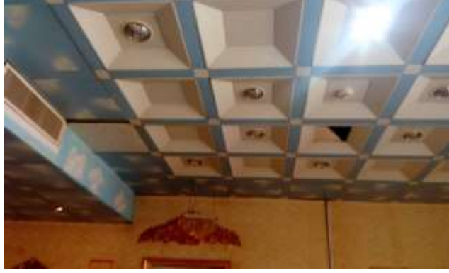
الصورة (9) توضح شكل الأسقف
