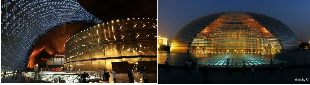
شكل ( 13.4 ) الإضاءة الليلية والتفاعل الاجتماعي مع المبنى
