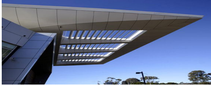
شكل (3-23) استخدام الألمنيوم في إكساء الواجهات الخارجية المصدر – 2018 www.3traxontechnologies.com
