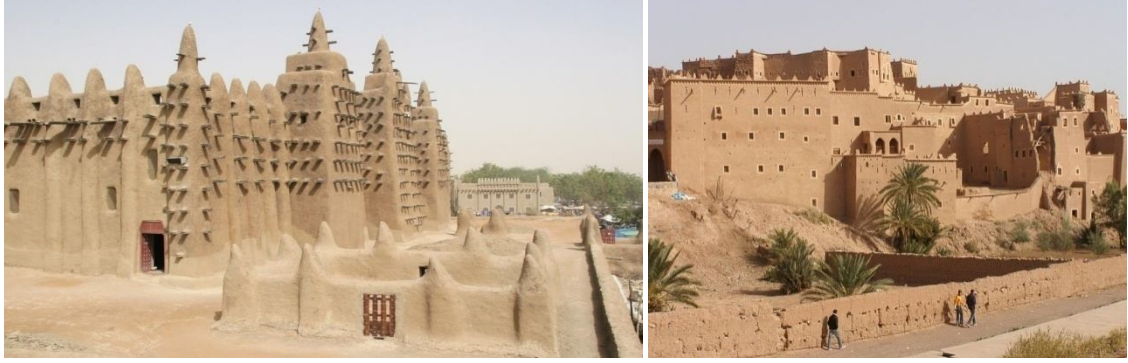
صورة رقم رقم (2-18) ورزازات البلدة القديمة (المدينة المنورة)
