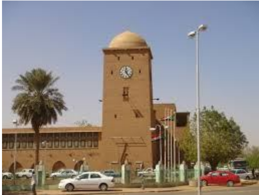
صورة رقم (77-2) مباني البوستة الخرطوم - الخرطوم
