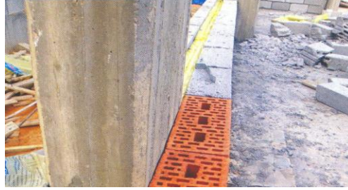
شكل (3-17) النظام التقليدي الذي فيه جدارين متوازيين بينهما المادة العازلة
