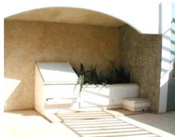
شكل (20-4) منظر لملقف الهواء
