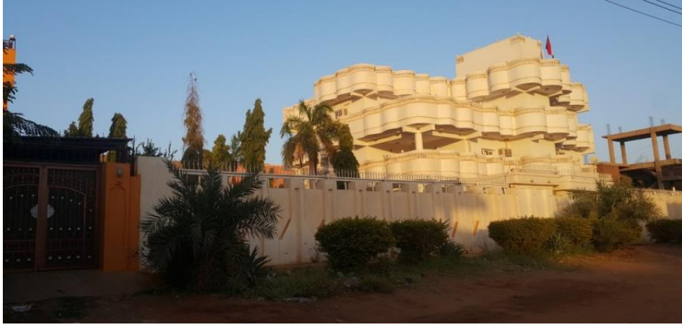
الشكل (4-36) صور للمبنى النموذج الثاني من الخارج ( الباحثة 2017 )
