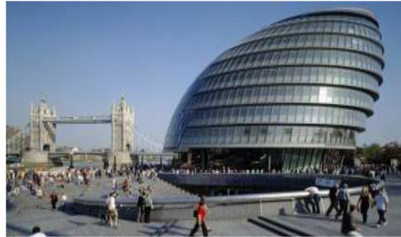
الشكل (13-2) مبنى (بلدية لندن) بمدينة لندن للمعماري (نورمان فوستر) عام (2000 - 2002 م) المصدر ( http://en.wikipedia.org/wiki )
