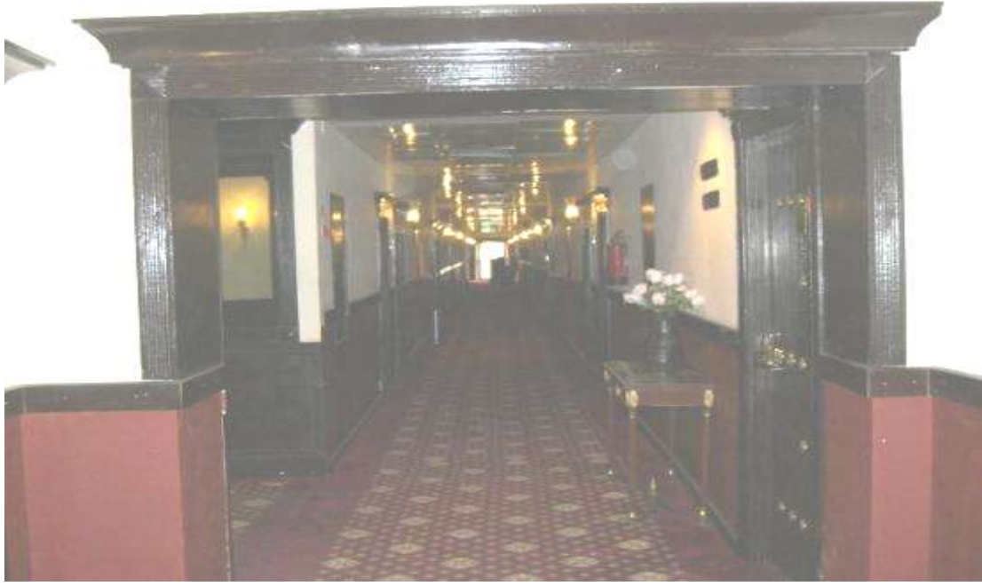
الصورة (٨٠) استخدام الألواح الخشبية في معالجة الجدران الداخلية وفي تصميم الأبواب في فندق (الجراند هوليداي فيلا) الخرطوم
