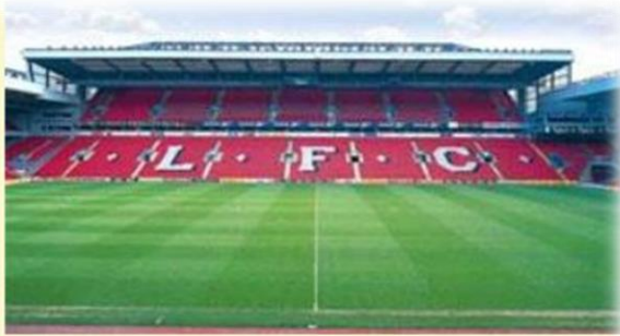
صورة توضح استخدام النجيل الطبيعي في ملعب الانفيلد رود في ليفربول
