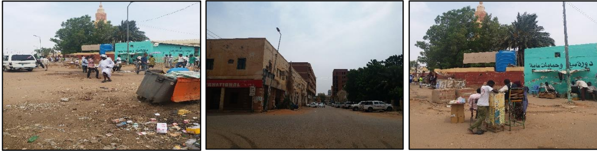
الصورة(5-12) توضح مشاكل الخدمات في منطقة وسط الخرطوم
