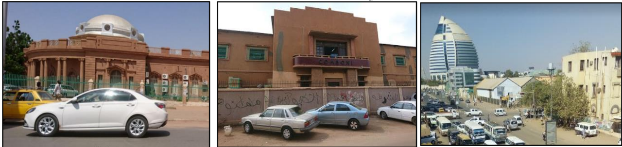
الصورة(5-10) توضح المشاكل البصرية في المباني
